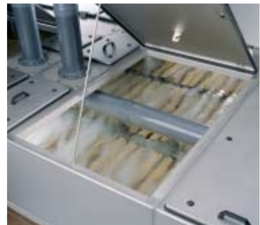
Belüftungselemente in Betrieb
